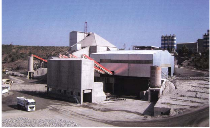
Toz çıkış noktaları kapatılan bir tesis örneği.
