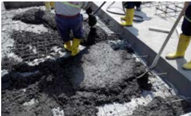
Şekil 6.2. Çimsa Beton Yol Yapımı
