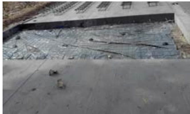
Şekil 6.3. Çimsa Beton Yol Yapımı
