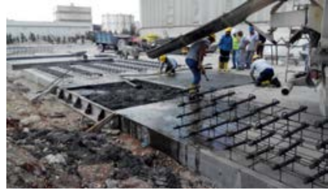
Şekil 6.1. Çimsa Beton Yol Yapımı
