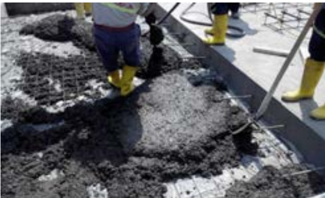
Şekil 6.2. Çimsa Beton Yol Yapımı
