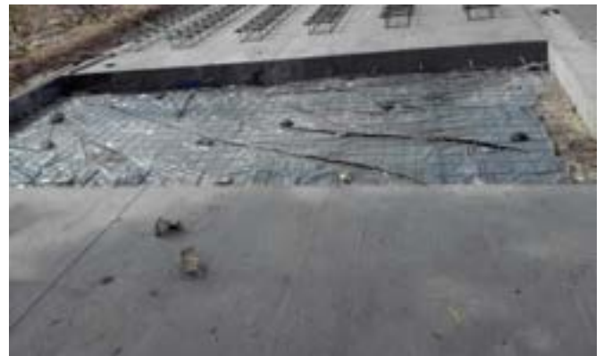
Şekil 6.3. Çimsa Beton Yol Yapımı
