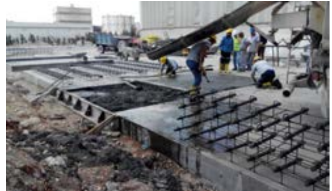
Şekil 6.1. Çimsa Beton Yol Yapımı
