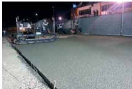
Figür 13: Serici ile betonun yerleştirilmesi
