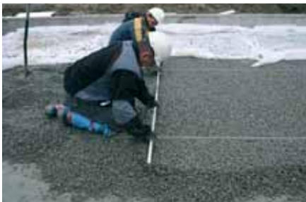
Figür 12: Manuel kaplama yapılması
