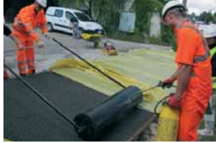
Figür 16: El silindiri ile sıkıştırma
