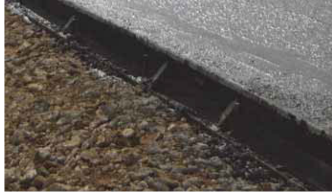
Şekil 16. Beton Yollarda Kullanılan Kalıp Sistemi
