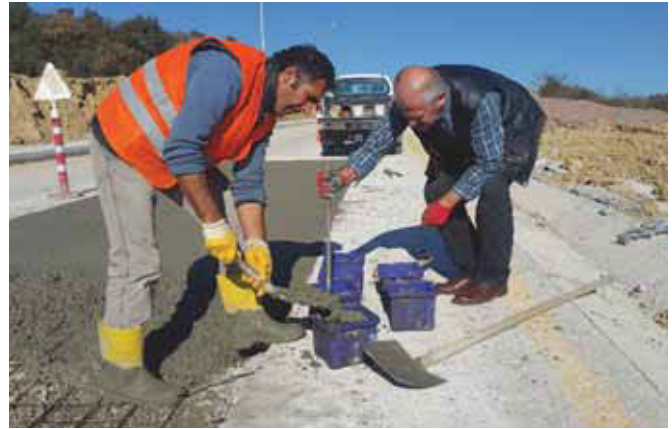
Şekil 22. Beton Kaplama Tamiri Sırasında Standart Numune Alımı
