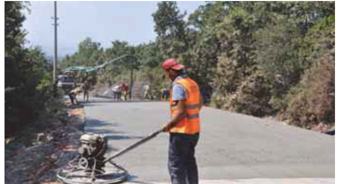
Şekil 19. Beton Yollarda Perdah Uygulaması
