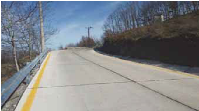
Şekil 15. Derz Uygulama ve İzolasyonu
