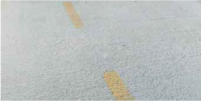
Şekil 13. Beton Yol Yüzey Dokusu
