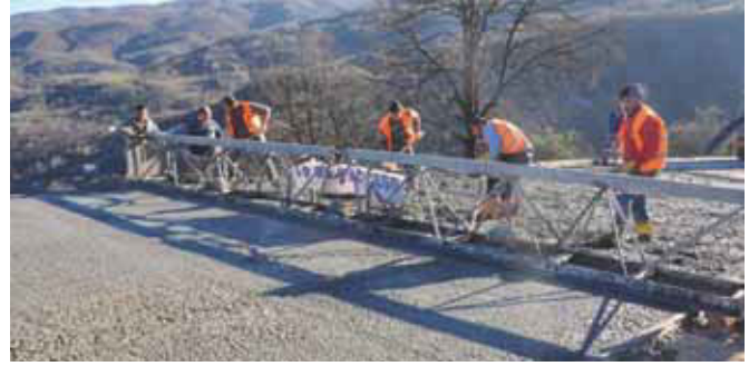
Şekil 18. Trafiğe Kapalı Bölgelerde Vibrasyonlu Mastar Kullanımı
