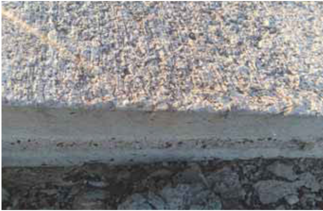
Şekil 21. Polipropilen Lif Donatılı Beton Yüzey Dokusu
