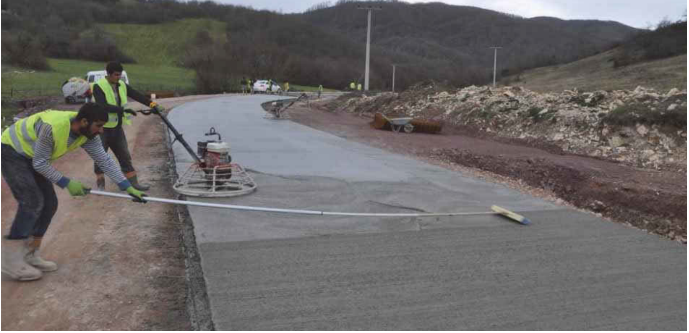
Şekil 20. Beton Yollarda Perdah ve Süpürge Uygulaması
