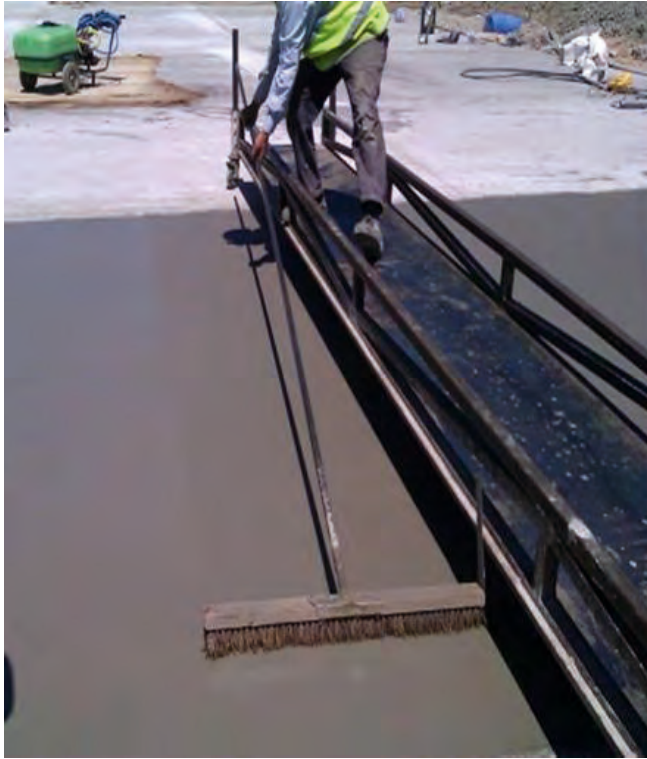
Resim 13: Beton yüzeyinin pürüzlendirilmesi ve betonun kuru
