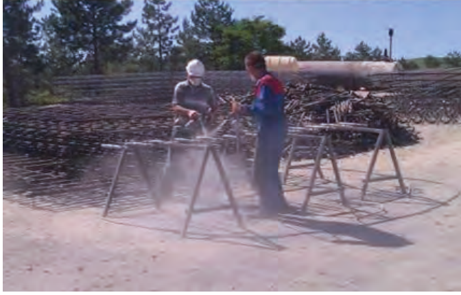
Resim 8: Dowel bar ve Tie barların hazırlanması
