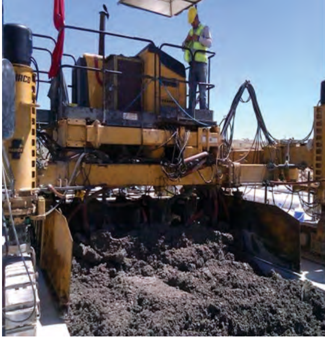
Resim 12: Finisher uygulaması ve işçilik
