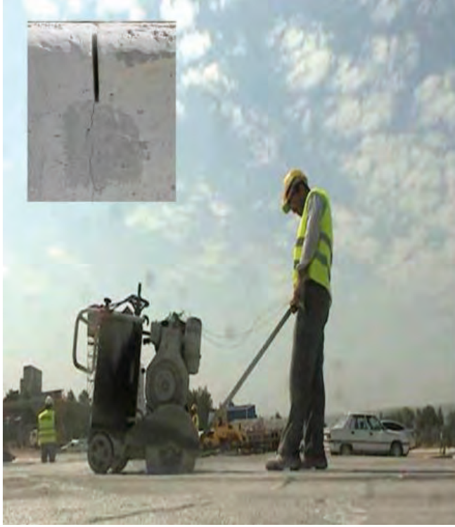
Resim 14: Derz kesimi ve kürü
