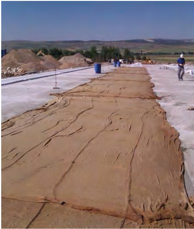
Resim 15: Betonun bakımı ve Tie-bar uygulaması
