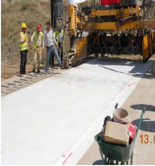
Resim 10: Geotekstilin serilmesi ve Dowel barların yerleştirilmesi
