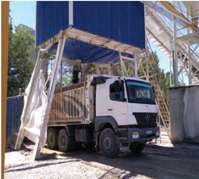
Resim 9: Grobetonun yüklenmesi ve serilmesi
