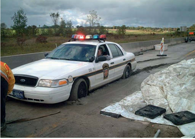
Resim 1: Soğuk havada betonun geç priz alması istenmeyen durumlara neden olabilir.
