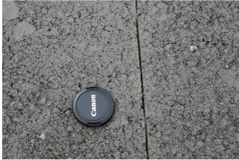
Şekil 10: Kesme işleminin ardından derzin yakın plan görüntüsü (CEMEX UK Materials firmasının müsaadesi ile alınmıştır)
