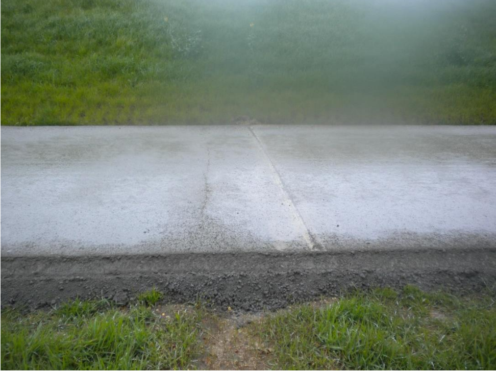
Şekil 7: Örnek: çok geç testerelenmiş bir büzülme derzi yakınında meydana gelen bir çatlama
