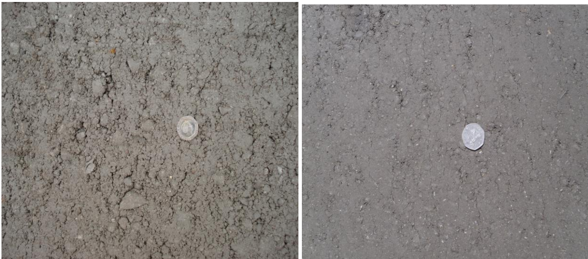
Şekil 6: 20mm (soldaki şekil) ve maksimum 10 mm (sağdaki şekil) agrega boyutu ile tipik yüzey kaplaması
