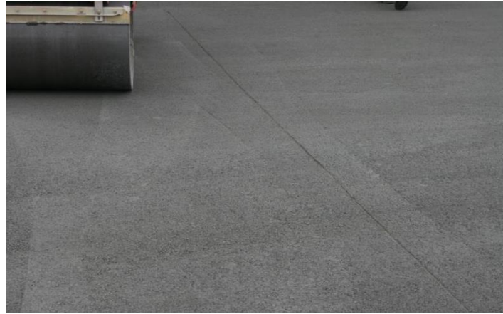
Şekil 12: Gerekli yoğunluğu elde etmek için yapılan son haddeme işlemi. Bitümlü emülsiyon olmadan, bu haddemede kapalı derz olacaktır (CEMEX UK Materials firmasının müsaadesi ile alınmıştır)
