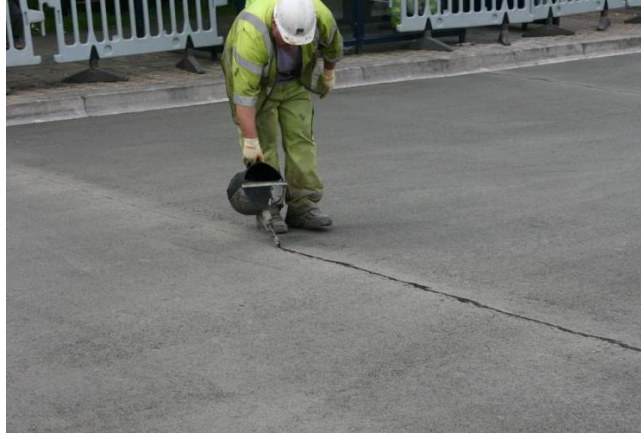
Şekil 11: Bitümlü emülsiyon ile elle doldurulan derz (CEMEX UK Materials firmasının müsaadesi ile alınmıştır)
