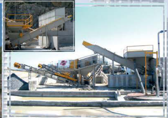
YAŞ BETON GERİ DÖNÜŞÜM TESİSİ
