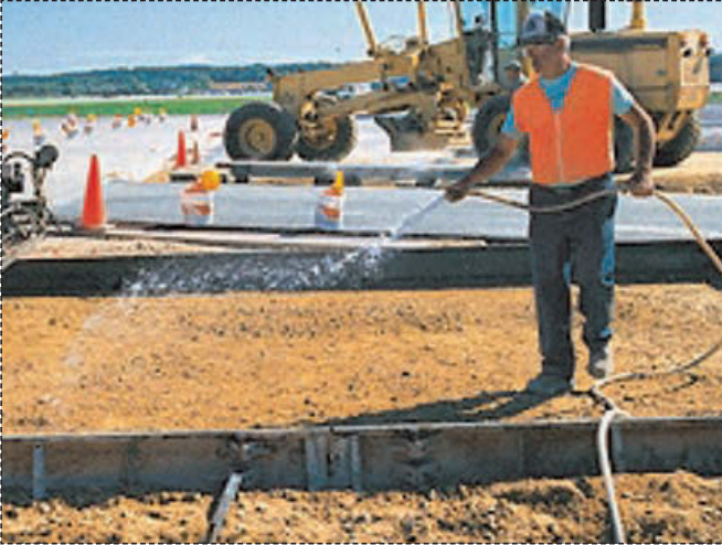
Resim 3: Zeminin nemlendirilmesi
