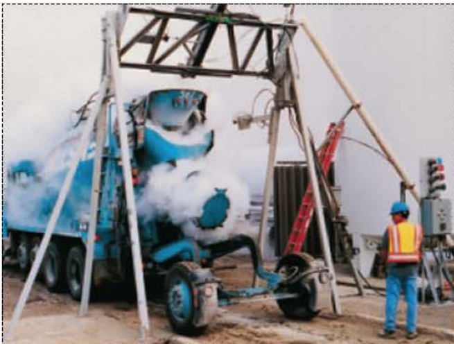
Resim 1: Betonun sıvı nitrojen ile soğutulması
