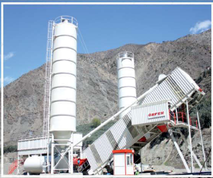
70 m 3 / saat MOBİL BETON SANTRALİ - ARTVİN / YUSUFELİ BARAJI
