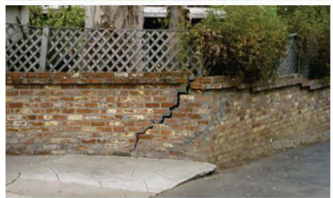
Şekil 13. Betonda oluşan biyolojik hasarlara örnekler
