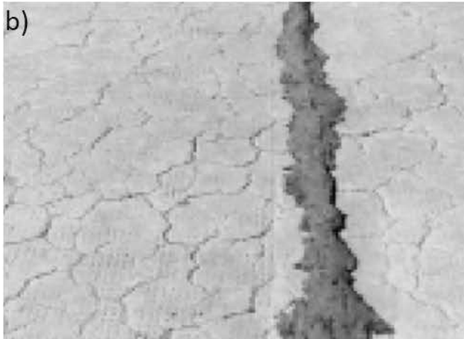
Şekil 9. ASR ve ACR hasarı a) ASR hasarına uğramış köprü ayağı (İzmir) b) Yaya yolu kaplamasında ACR çatlak (Ontario, Kanada)
