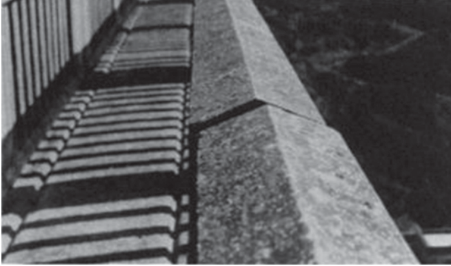
Şekil 6. Parapet elemanı, Val de Mare Barajı, Jersey [25,40]
