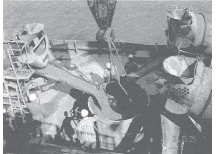
Şekil 12. Su altında tremi yöntemi ile beton dökümü [4].
