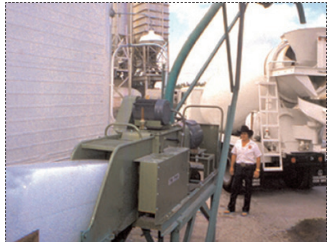
Resim 2: Beton karışım suyuna buz parçaları eklenmesi
