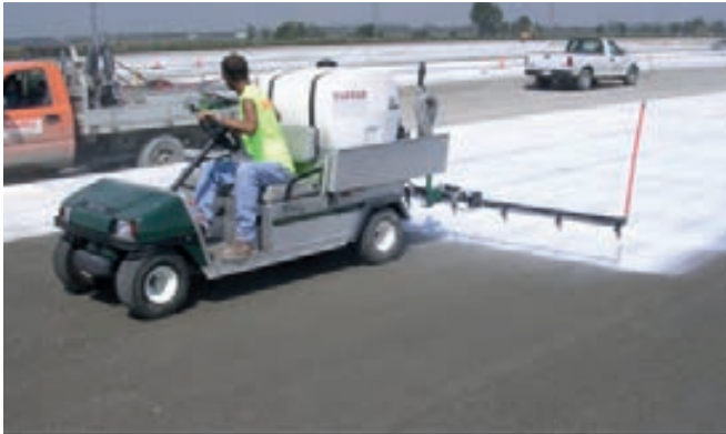
Şekil 9. SSB yolda beyaz renkli kür kimyasalı uygulanması [1]
