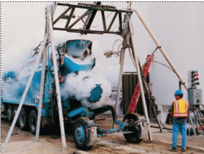
Resim 1: Betonun sıvı nitrojen ile soğutulması
