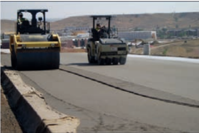
Şekil 7 . SSB kaplamanın çelik ve lastik tekerlekli silindirlerle sıkıştırılması [1]
