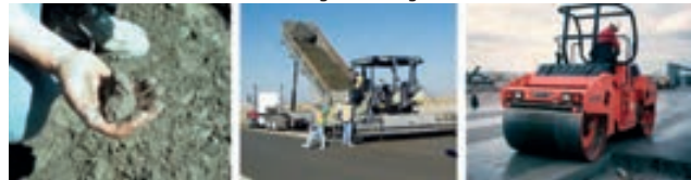
Şekil 1. Silindirle sıkıştırılmış beton yollar, geleneksel beton malzemeleri kullanılarak asfalt yol ekipmanları ile inşa edilebilirler [1].
