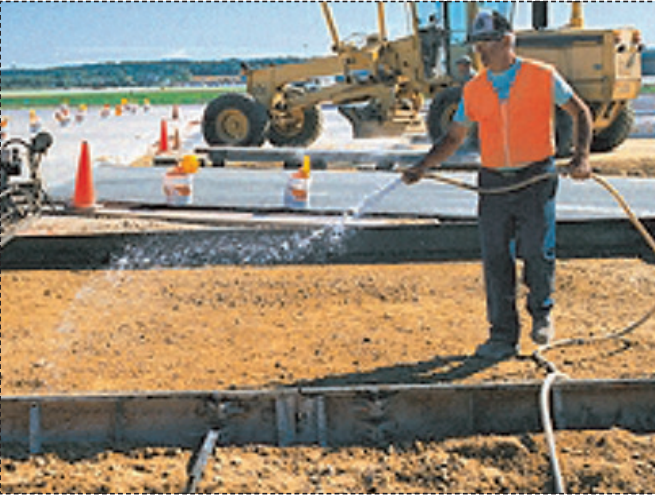
Resim 3: Zeminin nemlendirilmesi
