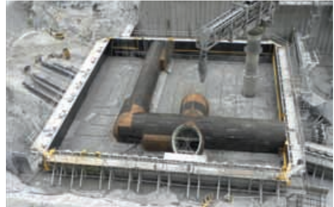
Şekil 1 Beton döküm yerinin hazırlanması
