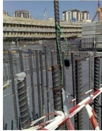
Şekil 2 Kablolu termometre'nin montajı
