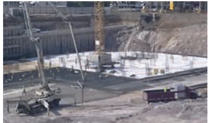
Şekil 3 Temel betonunun strafor ile kaplanmış uzaktan görüntüsü
