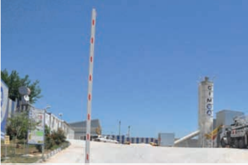
ÇİMSA ÇİMENTO SAN. ve TİC. A.Ş. KOZAN HAZIR BETON TESİSİ 4. YEŞİL NOKTA ÇEVRE ÖDÜLÜ
