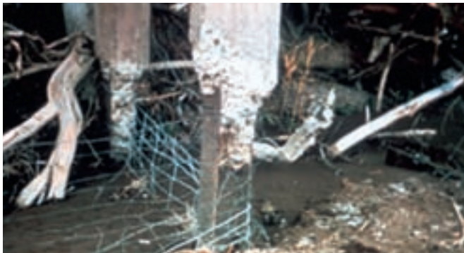
Resim 1: Kolonlarda sülfat atağı sonucu hasar
