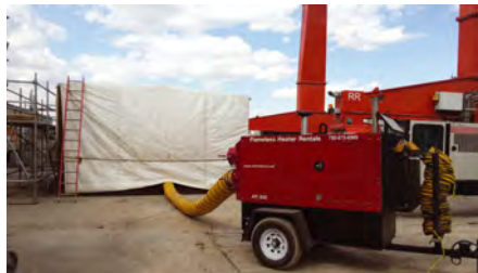
Resim 2: Isıtıcı ile ortam sıcaklığının kontrol edilmesi[7]
