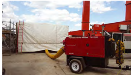
Resim 2: Isıtıcı ile ortam sıcaklığının kontrol edilmesi[7]
