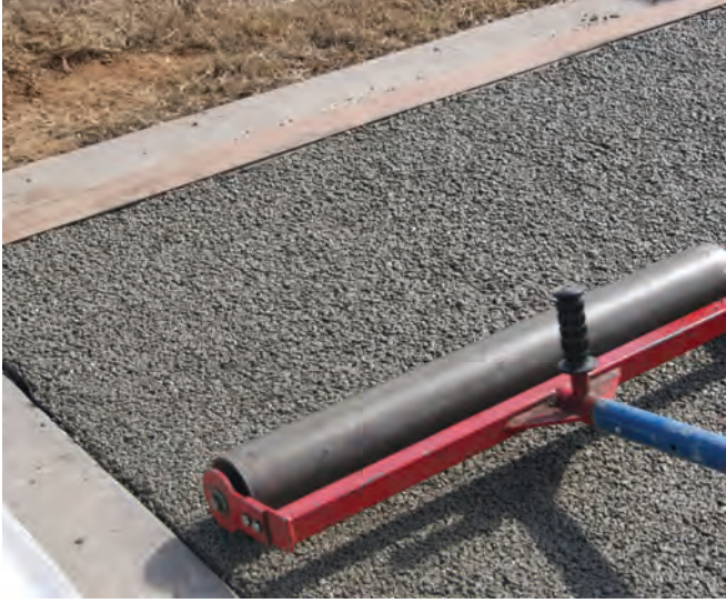
Şekil 10: Geçirimli beton kaplamanın yerleştirilmesi ve sıkıştırılması - 2
