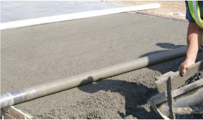
Şekil 12: Geçirimli betonun yüzey örtüsüyle kaplanarak kürlenmesi
