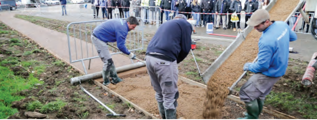
Şekil 9a: Geçirimli beton kaplamanın yerleştirilmesi ve sıkıştırılması - 1
