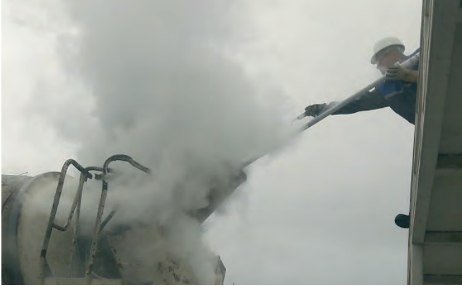
Şekil 3. Çamlıca Tesisi sıvı azot uygulaması ile taze betonun soğutulması
