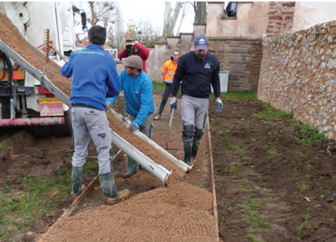
Şekil 9b: Geçirimli beton kaplamanın yerleştirilmesi ve sıkıştırılması - 1
