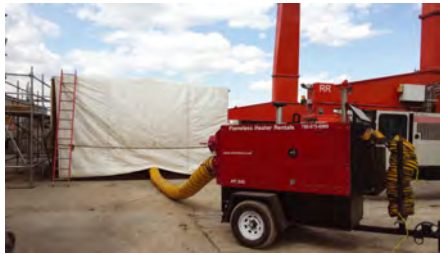
Resim 2: Isıtıcı ile ortam sıcaklığının kontrol edilmesi[7]
