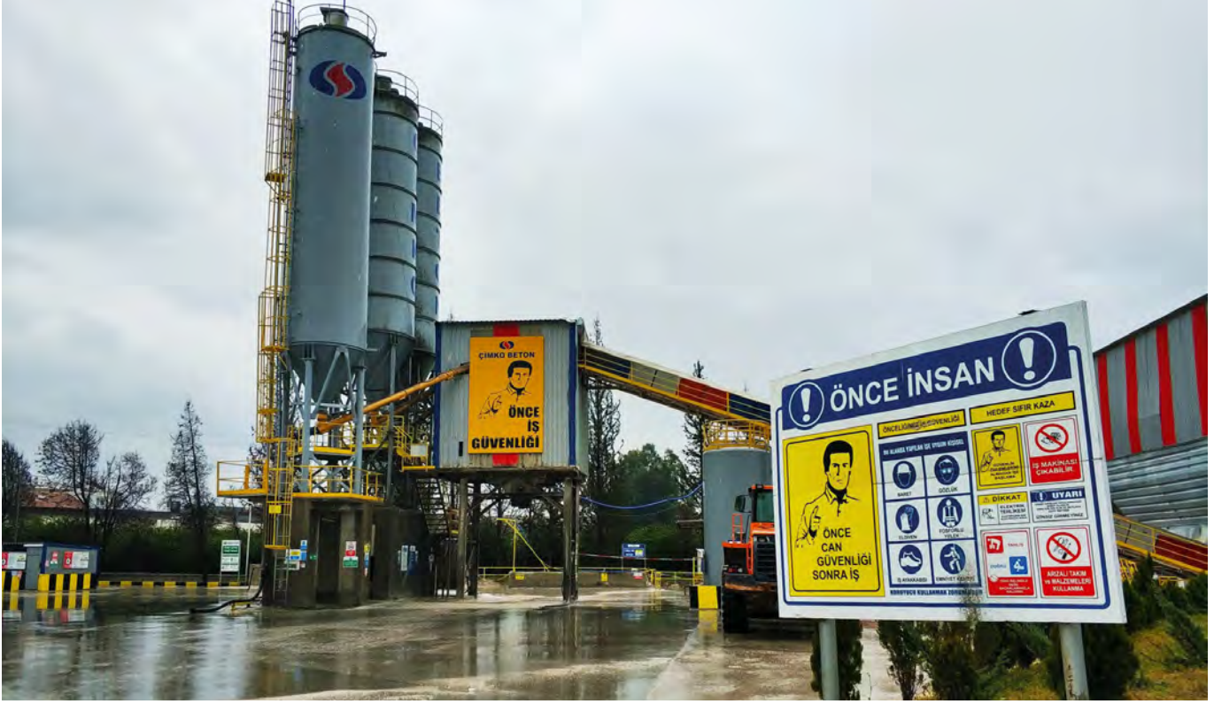
Çimko Osmaniye Hazır Beton Tesisi
