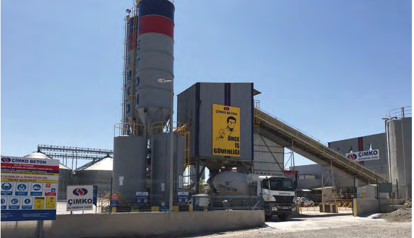
Çimko Altınşehir Hazır Beton Tesisi
