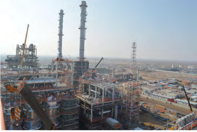
Doğalgazdan Benzin Üretim Tesisi Projesi, Aşkabat / RÖNESANS
