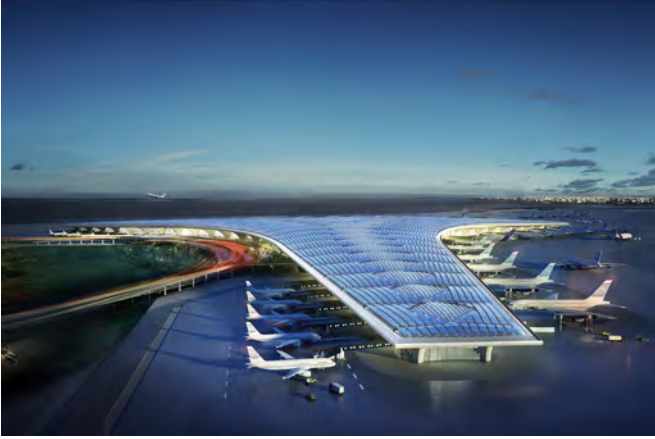
Kuveyt Uluslararası Havalimanı Terminal II Projesi, Kuveyt / LİMAK
