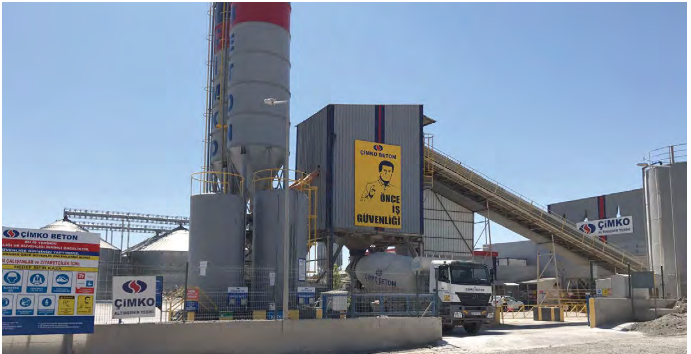
ÇİMKO Altınşehir Hazır Beton Tesisi
