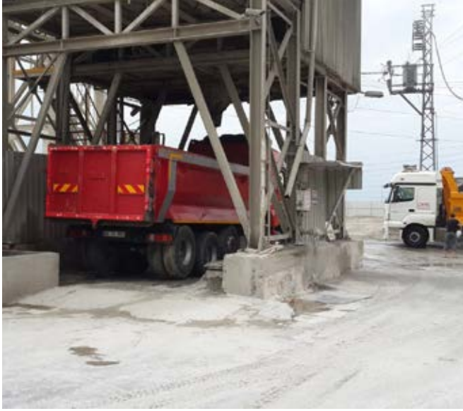
Şekil 2: Damperli kamyonu beton yüklenmesi
