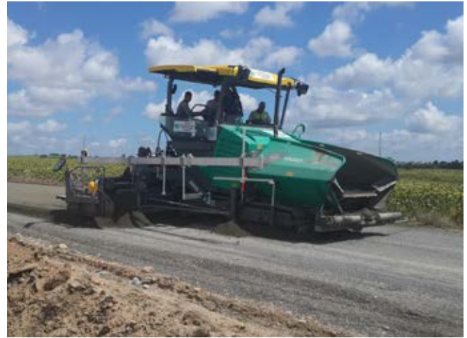
Şekil 4: SSB'nin yerleştirilmesi
