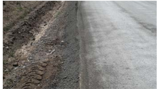
Şekil 8: Kısıtlanmamış yan kenarlar
