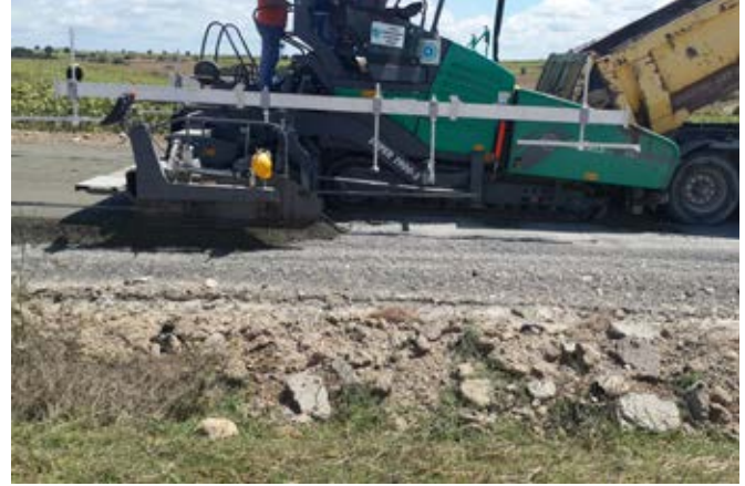
Şekil 3: Betonun kamyonun finişer önüne boşaltılması
