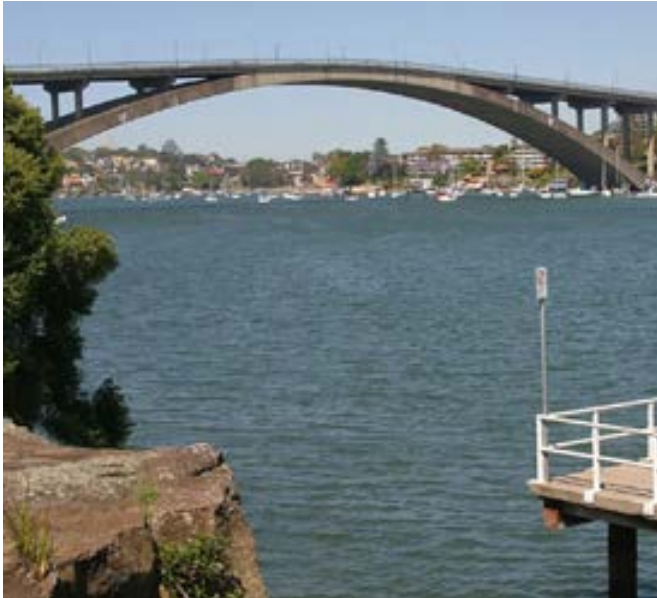
Gladesville Köprüsü, 1964 yılında tamamlandığında dünyanın en uzun tek açıklıklı beton kemeriydi. Fotoğraf: Bruce Elder
