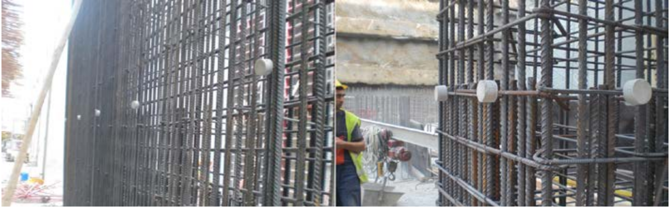
Fotoğraf 6: Beton pas payı elemanının perde ve kolon yapılarında kullanımı
