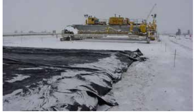
Şekil 4. Betonun ilk ısıyı ve hidrasyon ile açığa çıkan ısıyı hapsedmek için yerleştirme işleminden hemen sonra kür kaplamaları kullanmak gereklidir.
