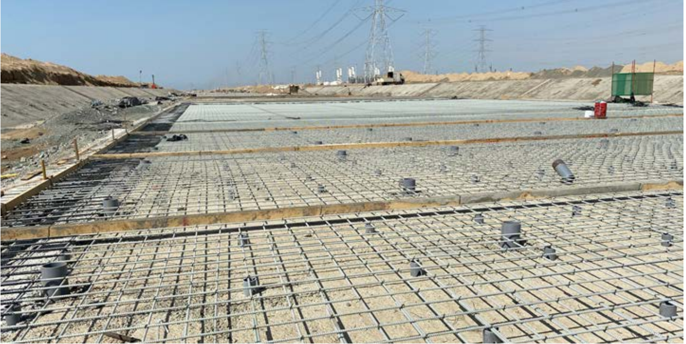
Şimdiye kadarki en büyük GFRP donatılı betonarme projesi
