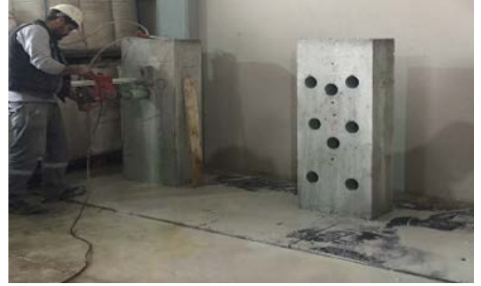
Şekil 3: Kolon Elemanlarından Karot Numunesi Alım İşlemi
