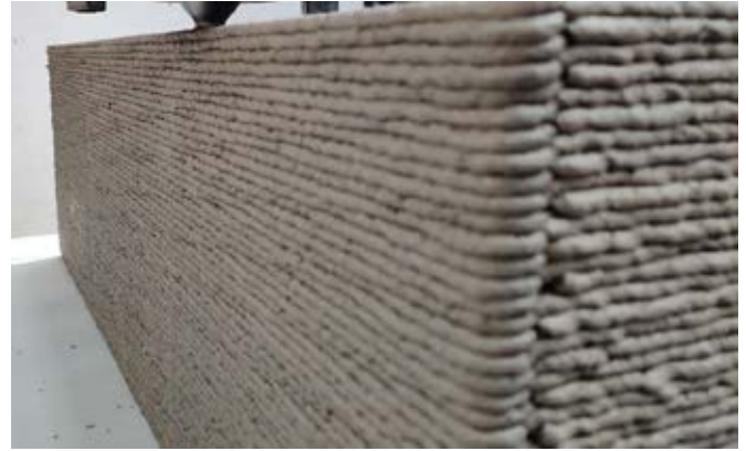
Bir duvar elemanının 3 boyutlu baskı katmanları.
