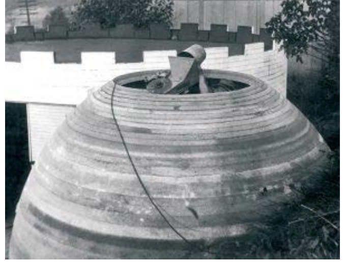
Şekil 5. Bir kişi ve bir Duvar İnşa Makinesi tarafından kubbeli bir yapı inşa ediliyor, bu ölçekte modern bir baskı sistemi ile henüz elde edilen bir başarı. Eğim arttıkça azalan katman yüksekliğine dikkat, bu, şu anda modern 3 boyutlu baskı sistemlerinde sarkan katmanları yönetmek için kullanılan bir tekniktir.
