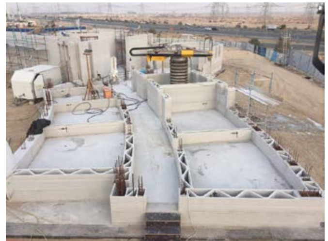
Şekil 4. Yapım aşamasında, modern bir 3 boyutlu baskılı bina, nispeten geleneksel takviye ve Apis Core tarafından yapılmış bir radyal baskı sistemine sahiptir.
