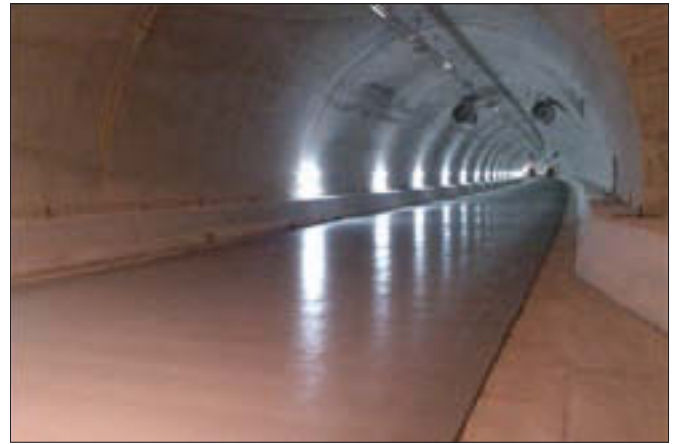
Şekil 5: Maxilotto 1'deki tünellerden birindeki beton yol
