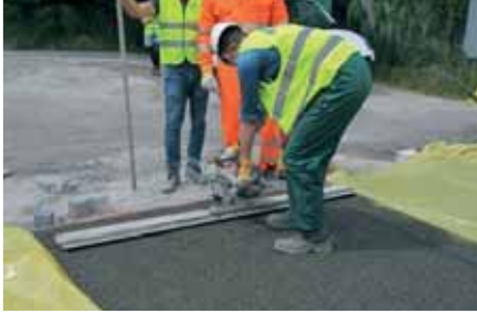
Figür 15: Vibratörlü perdah
