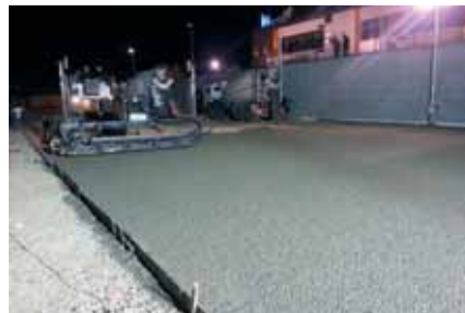
Figür 13: Serici ile betonun yerleştirilmesi
