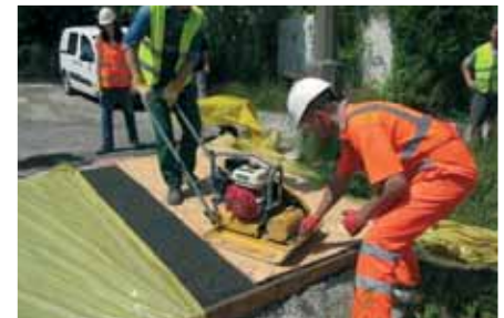
Figür 14: Mekanik sıkıştırma
