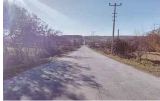
Şekil 2. 2003 Yılında Kocaeli ilinde İl Özel İdaresi Tarafından Yapılan İlk Beton Yol
