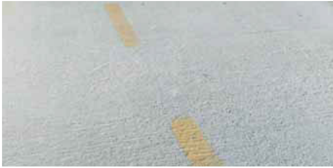
Şekil 13. Beton Yol Yüzey Dokusu
