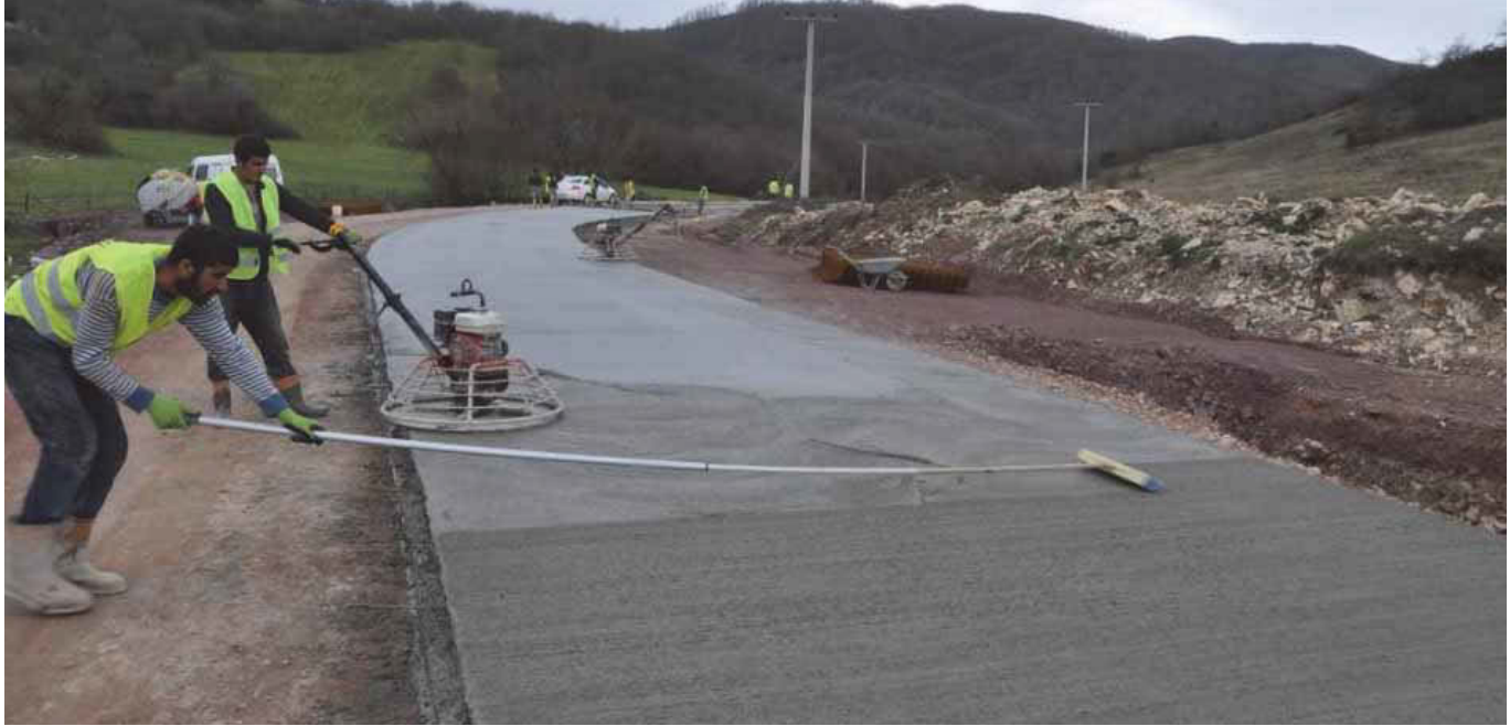
Şekil 20. Beton Yollarda Perdah ve Süpürge Uygulaması
