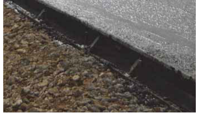
Şekil 16. Beton Yollarda Kullanılan Kalıp Sistemi
