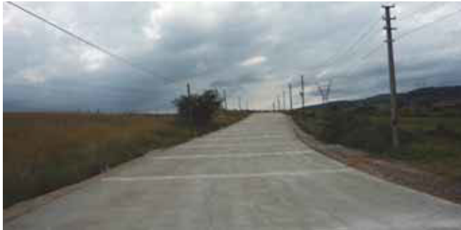
Şekil 14. Derz Kesme Yerlerinin Belirlenmesi
