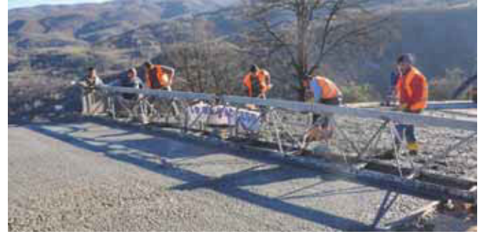
Şekil 18. Trafiğe Kapalı Bölgelerde Vibrasyonlu Master Kullanımı
