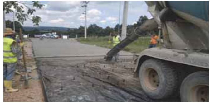
Şekil 17. Trafiğe Kapalı Bölgelerde Paspayı ve El Mastarı Uygulaması
