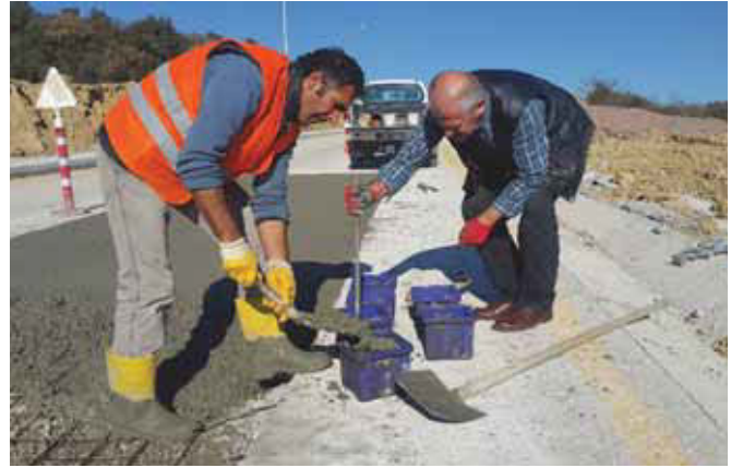
Şekil 22. Beton Kaplama Tamiri Sırasında Standart Numune Alımı
