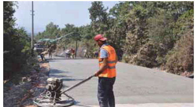
Şekil 19. Beton Yollarda Perdah Uygulaması
