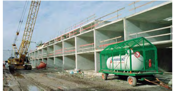
Figür 1: Harici ısıtma kullanılan yapı (Kaynak: VOBn)
