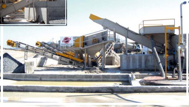
YAŞ BETON GERİ DÖNÜŞÜM TESİSİ
