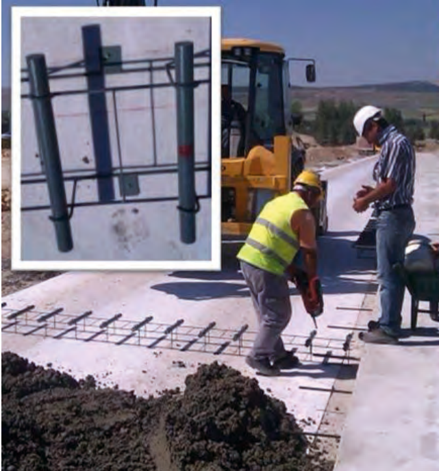
Resim 11: Dowel barların sabitlenmesi ve ana beton tabakasının dökümü
