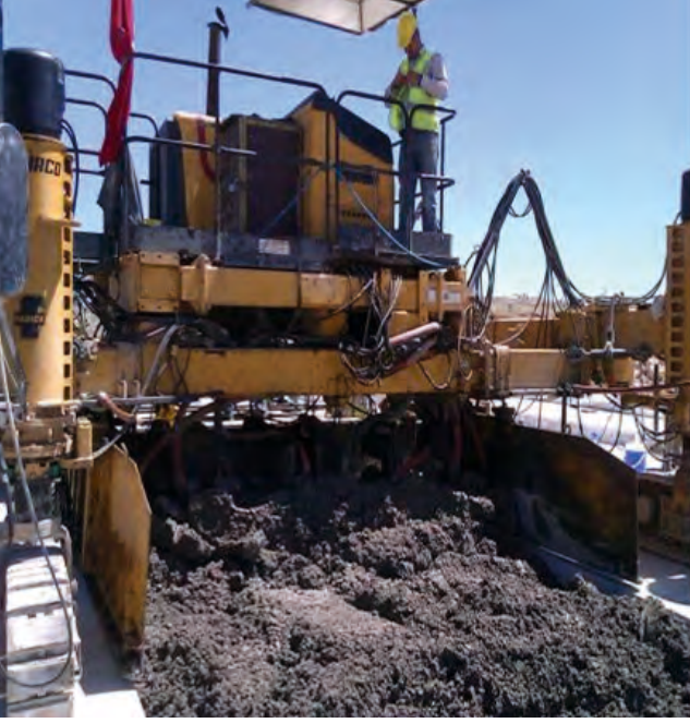
Resim 12: Finisher uygulaması ve işçilik
