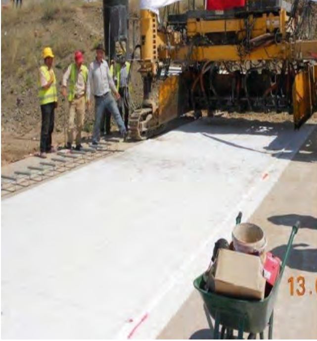
Resim 10: Geotekstil serilmesi ve Dowel barların yerleştirilmesi
