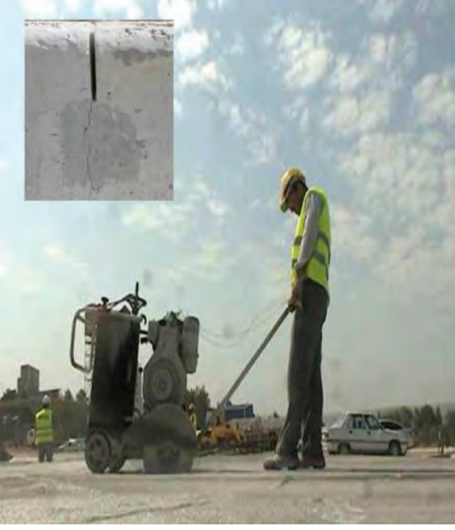
Resim 14: Derz kesimi ve kürü
