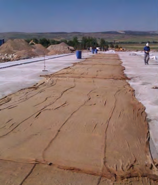
Resim 15: Betonun bakımı ve Tie-bar uygulaması
