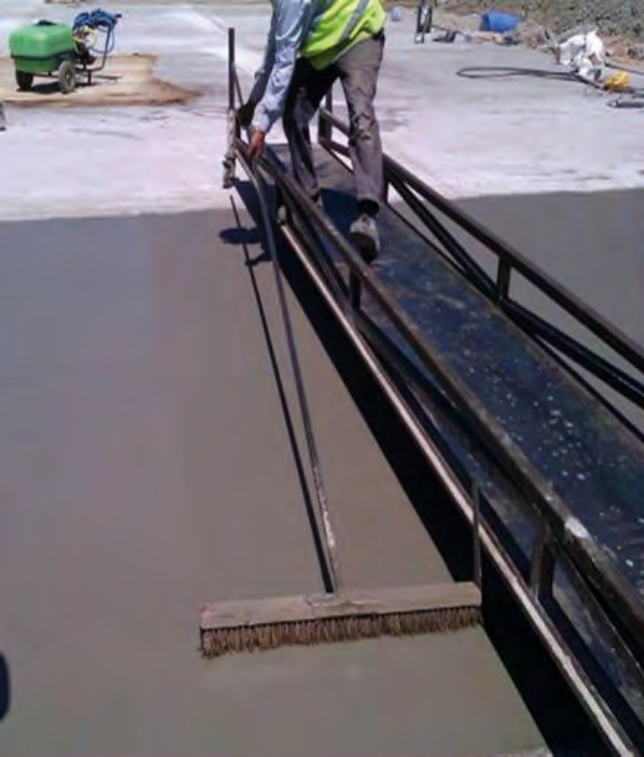
Resim 13: Beton yüzeyinin pürüzlendirilmesi ve betonun kürü
