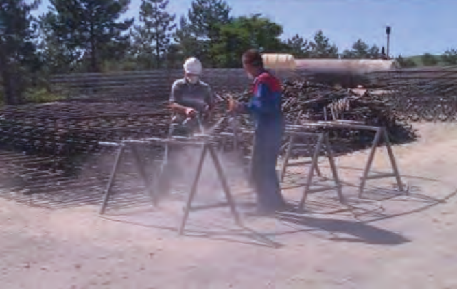
Resim 8: Dowel bar ve Tie barların hazırlanması
