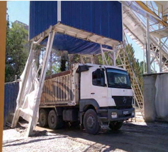
Resim 9: Grobetonun yüklenmesi ve serilmesi
