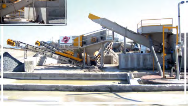
YAŞ BETON GERİ DÖNÜŞÜM TESİSİ
