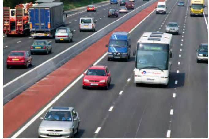
Şekil 5: Orta refüj beton bariyer kullanımı örneği (İngiltere)
