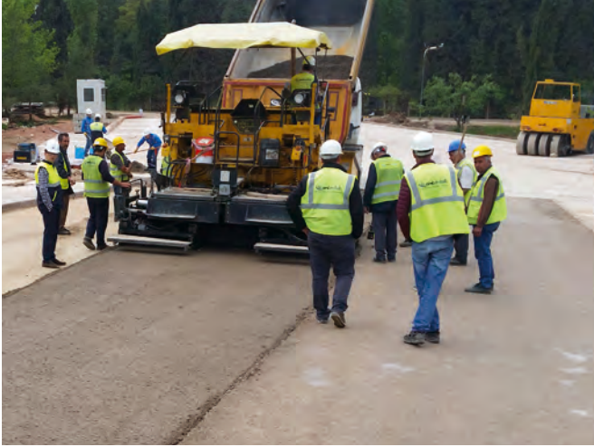
Şekil 2: Silindirle Sıkıştırılmış Beton Yol uygulaması (Bursa)
