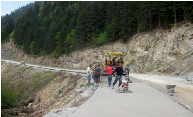
Şekil 3: Karadeniz Bölgesi kırsal kesim beton yol uygulaması
