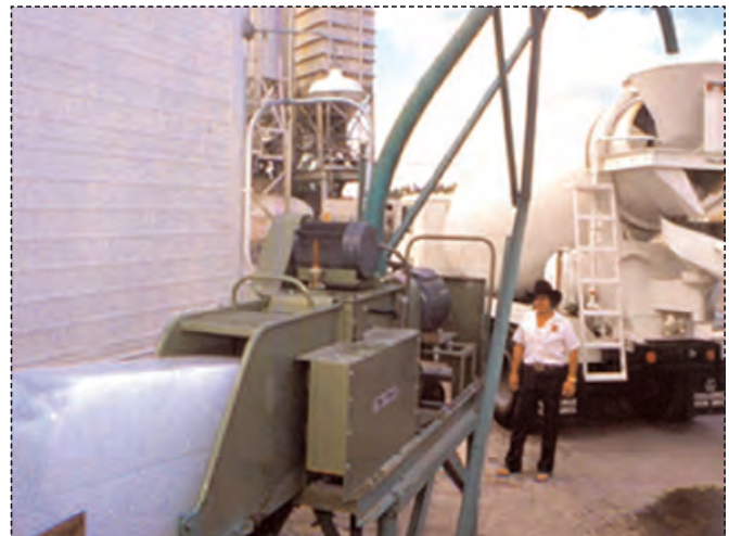
Resim 2: Beton karışım suyuna buz parçaları eklenmesi
