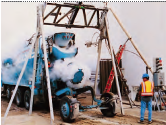
Resim 1: Betonun sıvı nitrojen ile soğutulması
