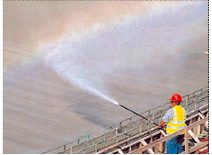
Resim 4: Yağmurlama (fogging) ile hem hava soğutulur hemde bağıl nem artar.
