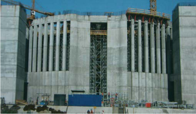
Şekil 8. Sinüzoidal beton kalkan parçası ve bu kalkan kabuğun yer aldığı viyadüğün göl tarafından görünümü [39].
