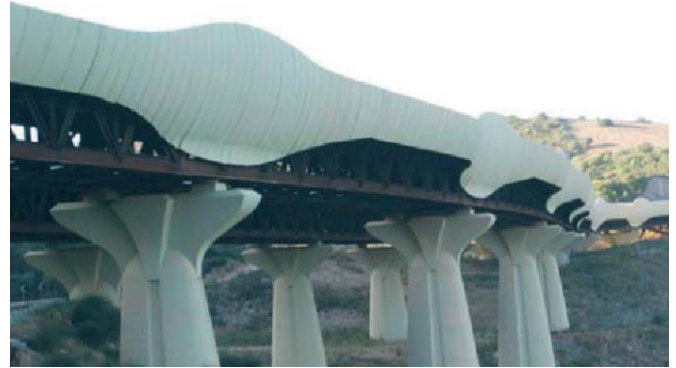
Şekil 8. Sinüzoidal beton kalkan parçası ve bu kalkan kabuğun yer aldığı viyadüğün göl tarafından görünümü [39].
