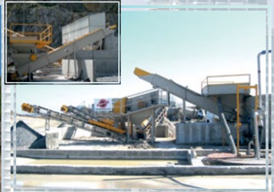
YAŞ BETON GERİ DÖNÜŞÜM TESİSİ
