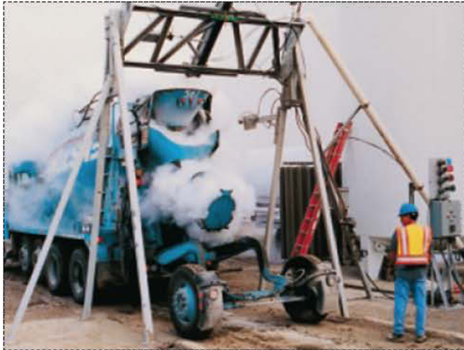
Resim 1: Betonun sıvı nitrojen ile soğutulması
