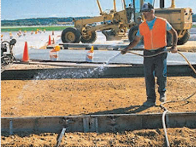
Resim 3: Zeminin nemlendirilmesi
