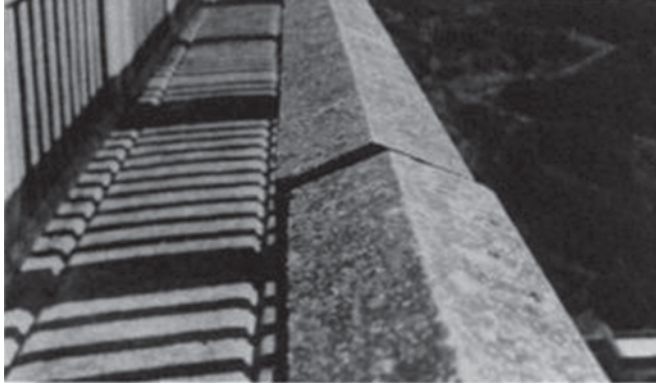
Şekil 6. Parapet elemanı, Val de Mare Barajı, Jersey [25,40]
