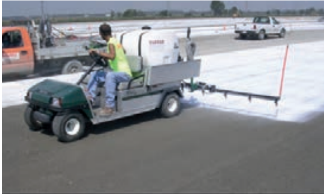
Şekil 9. SSB yolda beyaz renkli kür kimyasalı uygulanması [1]
