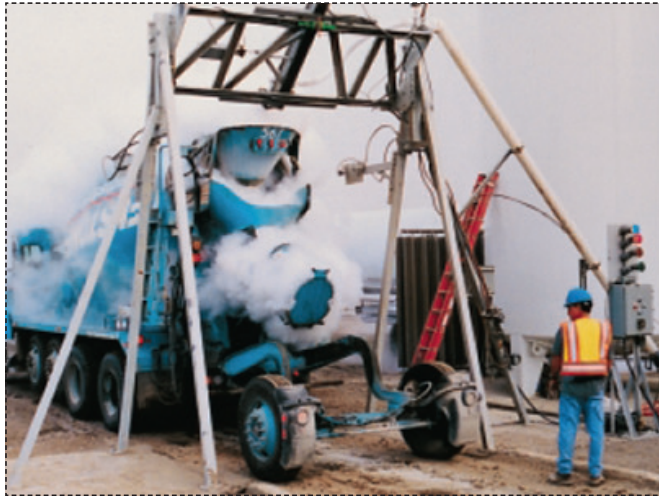
Resim 1: Betonun sıvı nitrojen ile soğutulması
