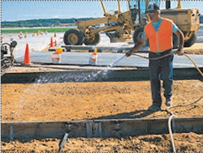
Resim 3: Zeminin nemlendirilmesi
