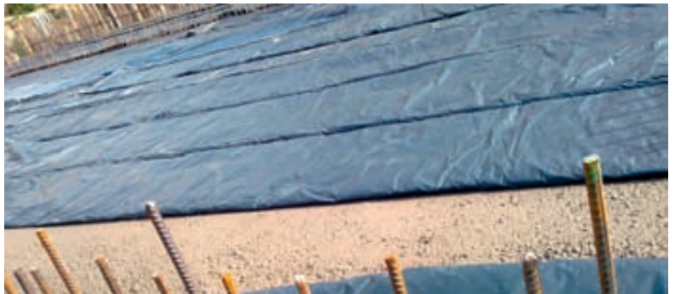
Şekil 3.2. (a) Termocouple kablolarının 3 girişli data logger montajı, (b) betonun yorganlar ile korunması
