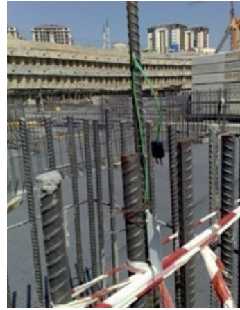
Şekil 2 Kablolu termometre'nin montajı
