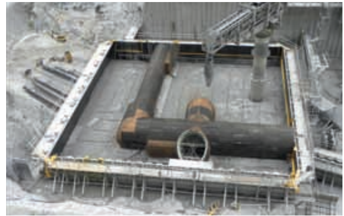
Şekil 1 Beton döküm yerinin hazırlanması
