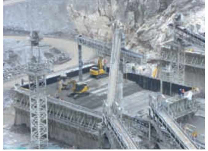
Şekil 2 Beton dökümü
