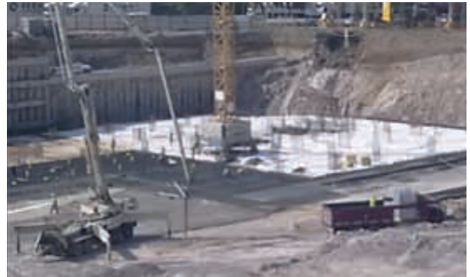
Şekil 3 Temel betonunun strafor ile kaplanmış uzaktan görüntüsü
