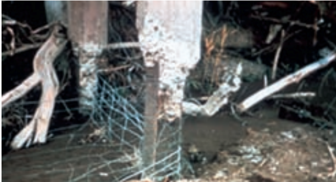
Resim 1: Kolonlarda sülfat atağı sonucu hasar
