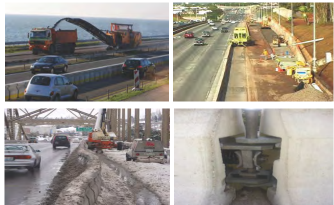
Şekil 14. Hareketli bariyerler ile yol çalışması güvenliği
