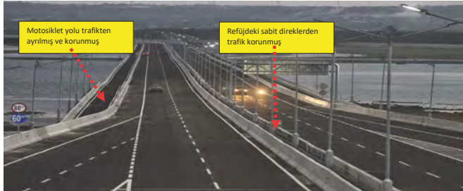
Şekil 16. Örnek beton bariyer uygulaması
