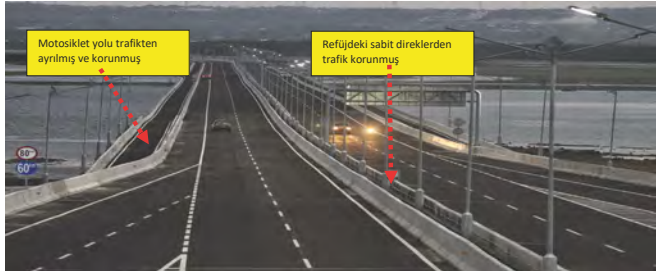
Şekil 16. Örnek beton bariyer uygulaması
