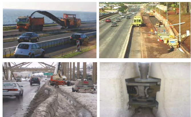
Şekil 14. Hareketli bariyerler ile yol çalışması güvenliği
